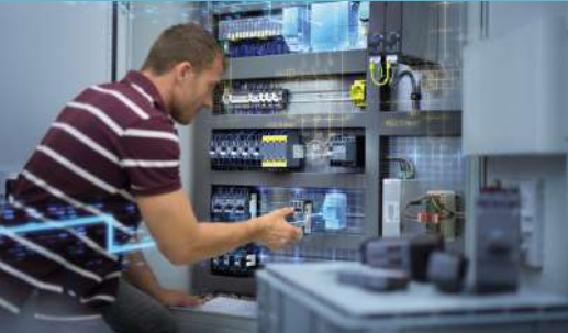
Construcción de paneles
